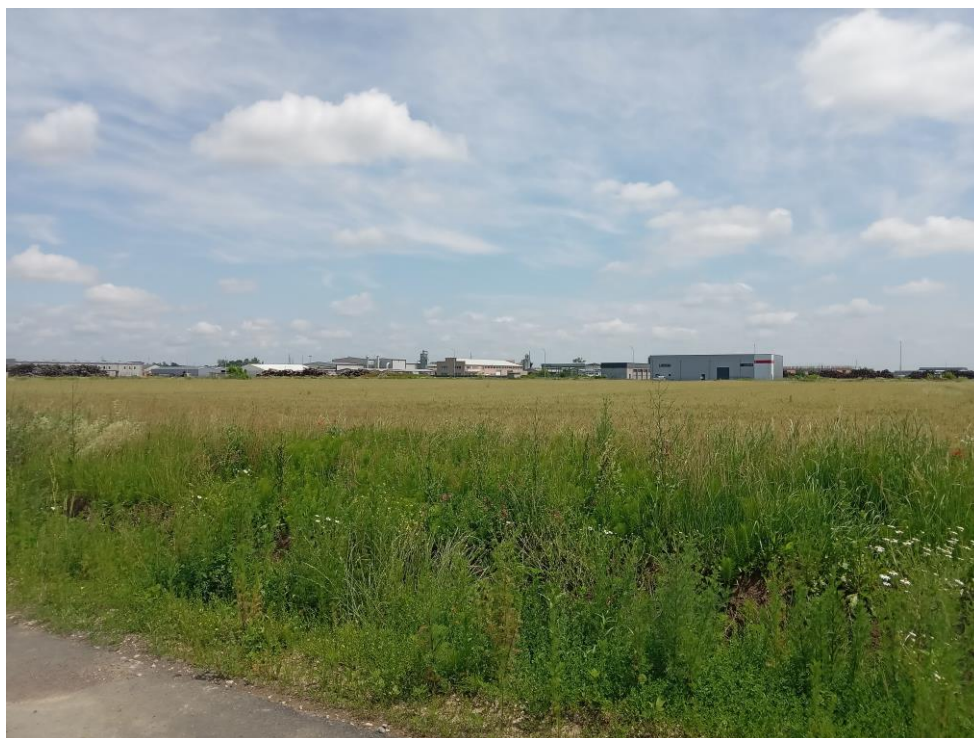
Slika 41. Pogled na izgrađene objekte unutar poduzetničke zone Sječine I faza, fotodokumentacija s lokacije zahvata, lipanj 2023.
