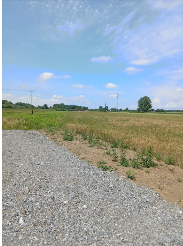
Slika 42. Dalekovodi na području poduzetničke zone, fotodokumentacija s lokacije zahvata, lipanj 2023.
